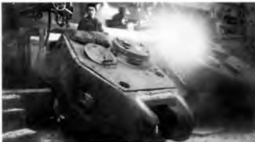
Приварка крыши к основе башни Т-34-85. Уралвагонзавод, 1944 год
