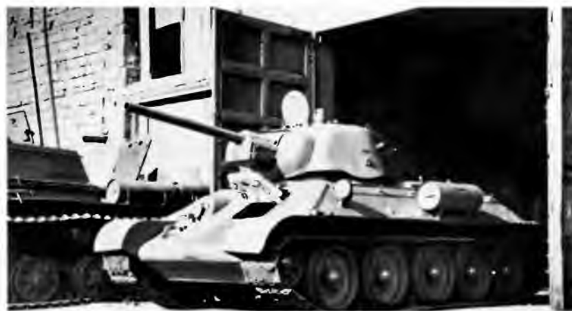
Танк Т-34 со штампованной башней производства УЗТМ покидает сборочный цех Челябинского Кировского завода, август 1943 года
