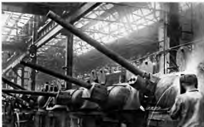
Сборка башен в цеху Челябинского Кировского завода. 1943 год. У передней башни еще не установлена подвижная бронировка пушки Ф-34
