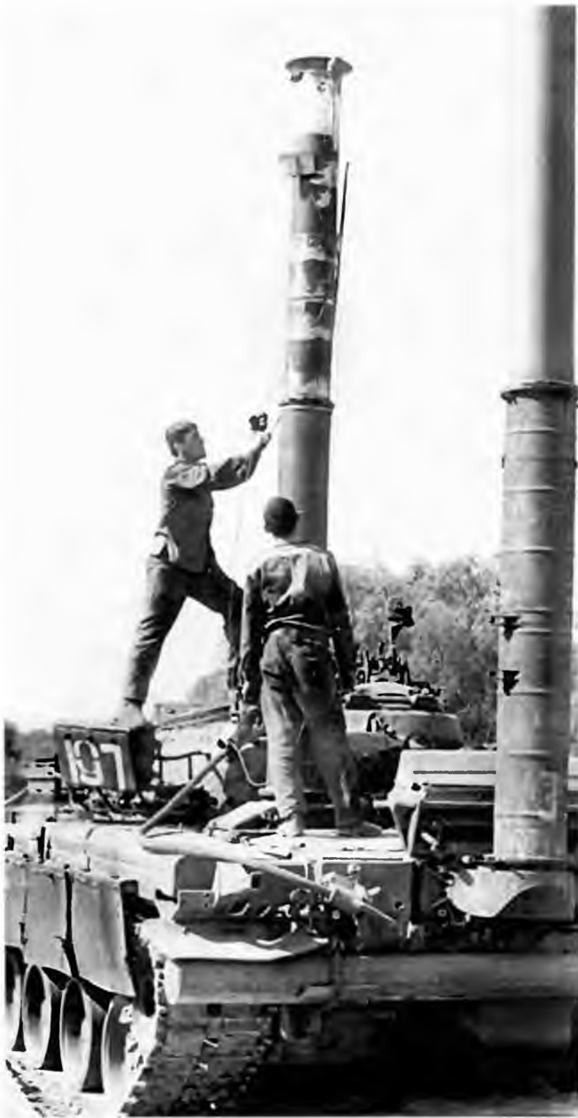
Установка оборудования ОПВТ на Т-80БВ. Северная группа войск, 1991 год
