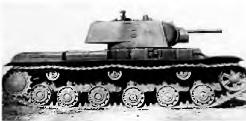
Серийный танк KV-1 выпуска 1941 г. с пушкой Ф-32. Судя по угольным дополнительным топливным бакам на надгусеничной полке, эта машина изготовлена после начала войны
