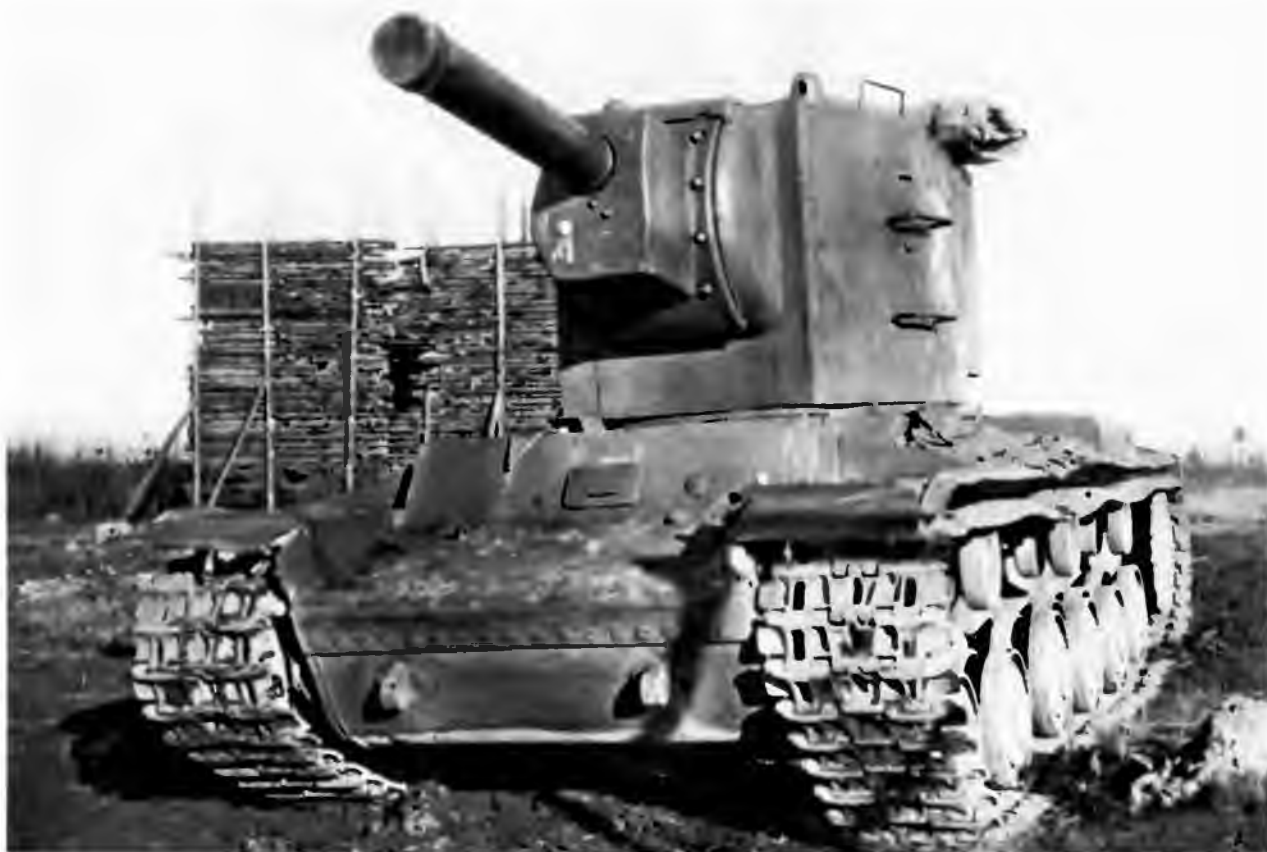
Опытный танк KB с «пониженной» башней и 152-мм гаубицей. 1940 год
