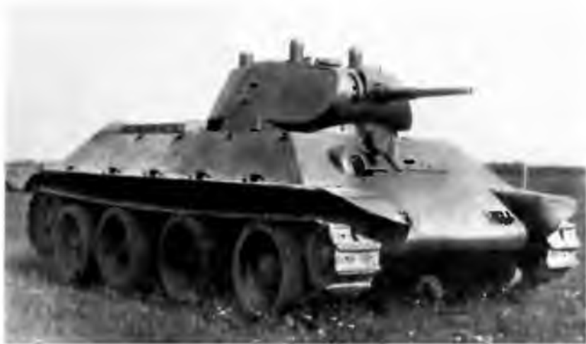
Опытный образец колесно-гусеничного танка А-20 во время испытаний. 1939 год
