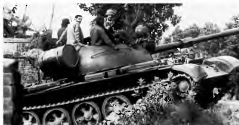
Индийский Т-55 выдвигается к линии фронта. Индо-пакистанский конфликт, 1971 год. На стволе 100-мм пушки видна имитация эжектора, облегчавшая опознавание танков в бою
