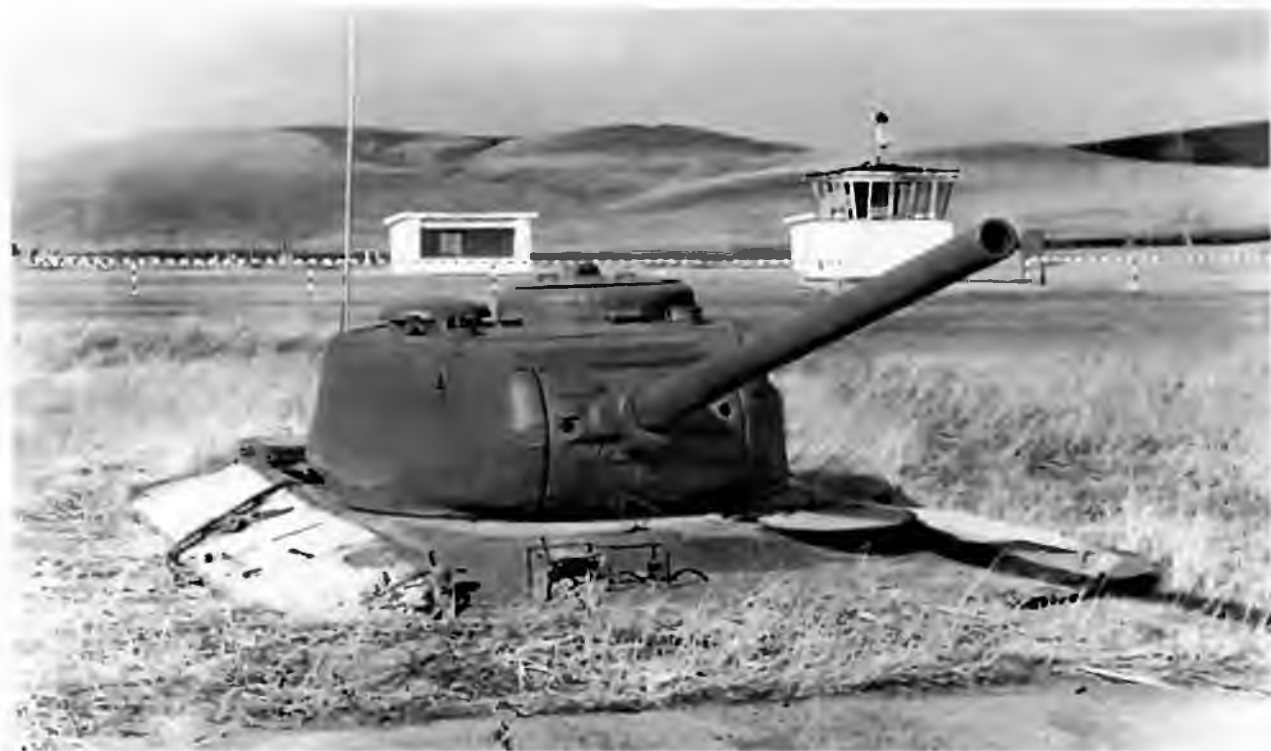
Долговременная огневая точка, сооруженная с использованием башни и корпуса танка Т-44 на советско-китайской границе
