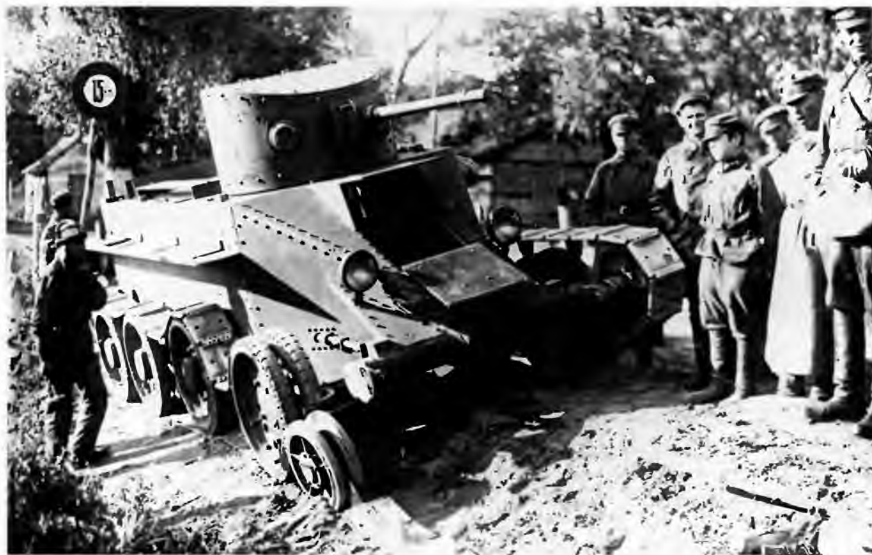
Личный состав осматривает танк БТ-2 с вышедшей из строя ходовой частью. 1935 год
