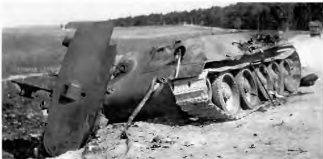
Подбитая «тридцатьчетверка» самых ранних выпусков, о чем говорит сплошная гнутая лобовая деталь корпуса. В кормовой части крыши башни хорошо виден стакан антенного ввода, что также было характерно для первых серийных машин. Лето 1941 года
