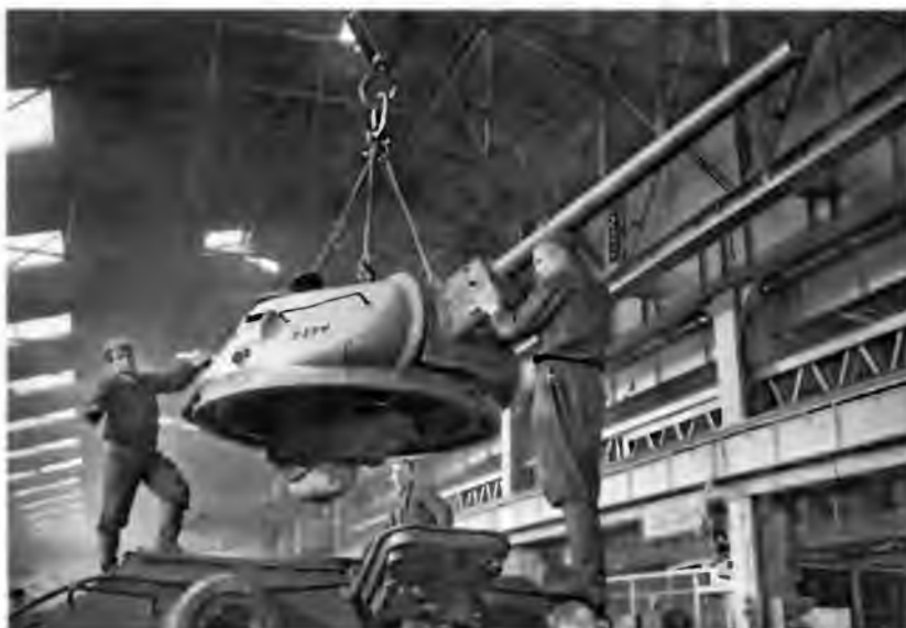
Сборка танков Т-34 в цеху завода №112 «Красное Сормово». Август 1942 года
