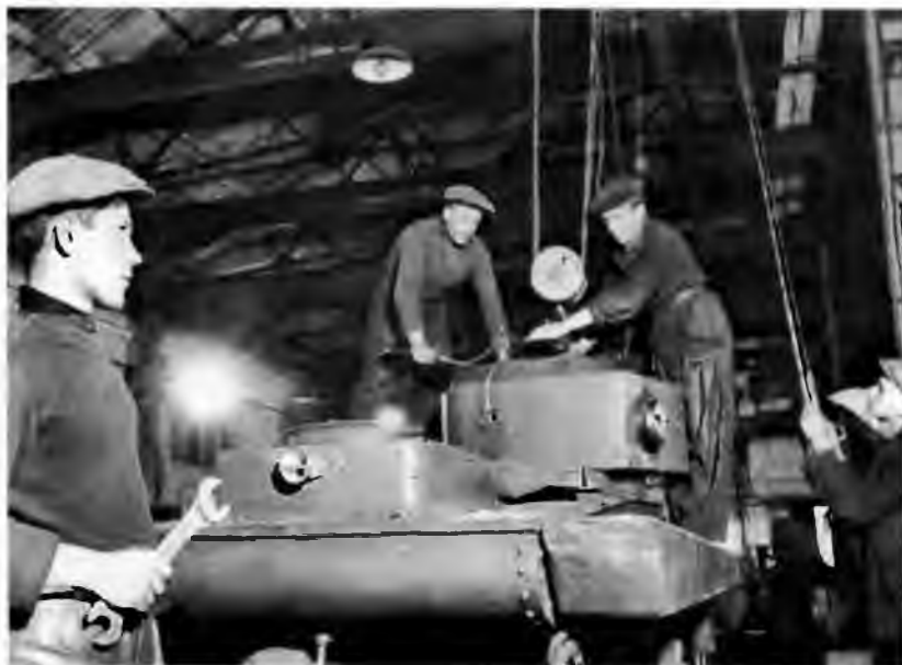
Ремонт танка Т-37А на одном из предприятий Ленинграда. 1941 год
