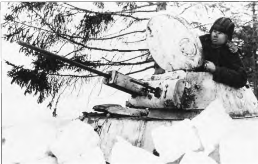
20-мм танковая пушка ТНШ в танке Т-60 (030) лейтенанта Иванова. Декабрь, 1941 г.
