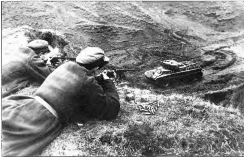
Обстрел танка БТ-7 из винтовки бронебойной пулей. 1938 г.
