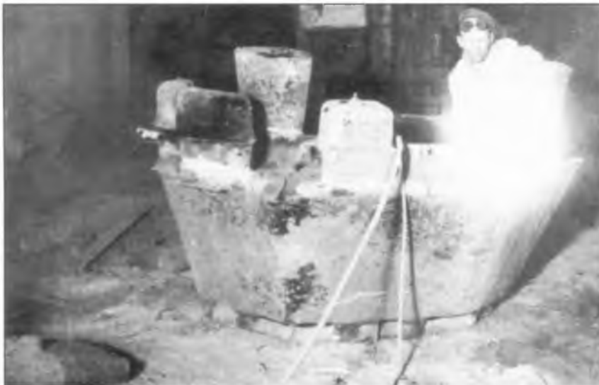
Удаление литейных прибылей после отливки башни Т-34. 1942 г.
