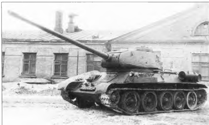
Т-34-85, перевооруженный 100-мм пушкой ЗИС-100, во дворе завода № 92. 1945 г.
