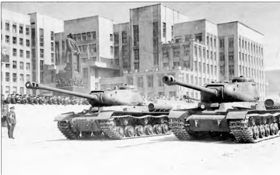
Два ИС-2, вооруженные Д-25 с поршневым затвором (передний) и клиновым (задний) на параде в г. Минск. 1945 г.
