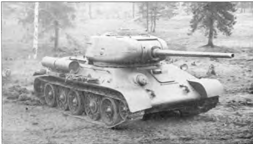
Испытания танка Т-34 с башней Т-43 на погоне 1600-мм и 85-мм пушкой Д-5Т, 1943 г.
