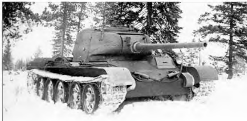
Второй прототип Т-44, после выдвигания казенной части орудия Д-5Т вперед
