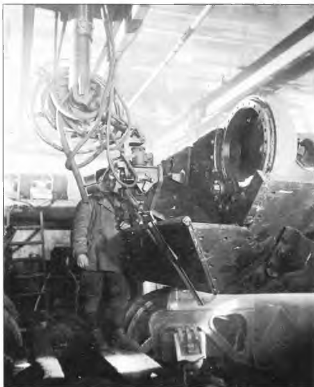
Сварка бронекорпуса Т-34 полуавтоматом Е. Патона. 1942 г.
