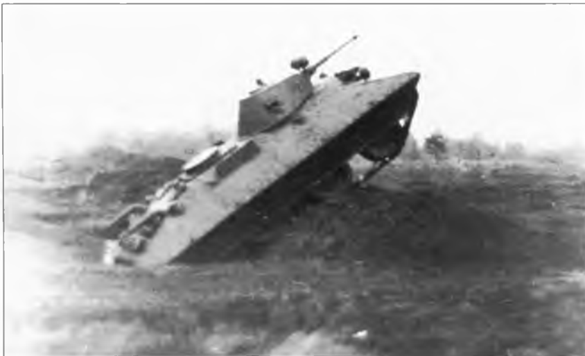
Танк БТ-СВ в ходе испытаний на препятствиях. 1938 г.
