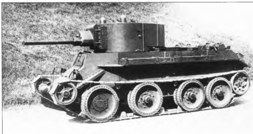
Танк БТ-7А, вооруженный 76,2-мм пушкой Л-11, на испытаниях. 1940 г.
