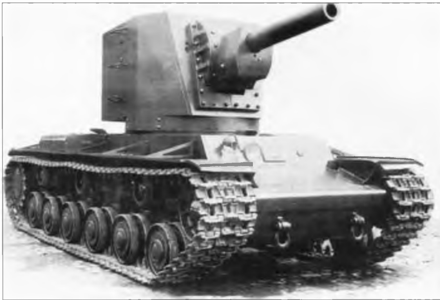
Танк КВ (КВ-2) с установкой МТ-1 в «большой башне». 1940 г.
