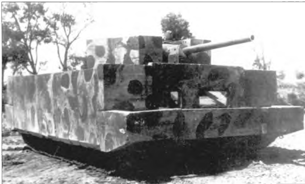
Т-34, экранированный железобетоном по схеме группы Цыганкова. 1943 г.
