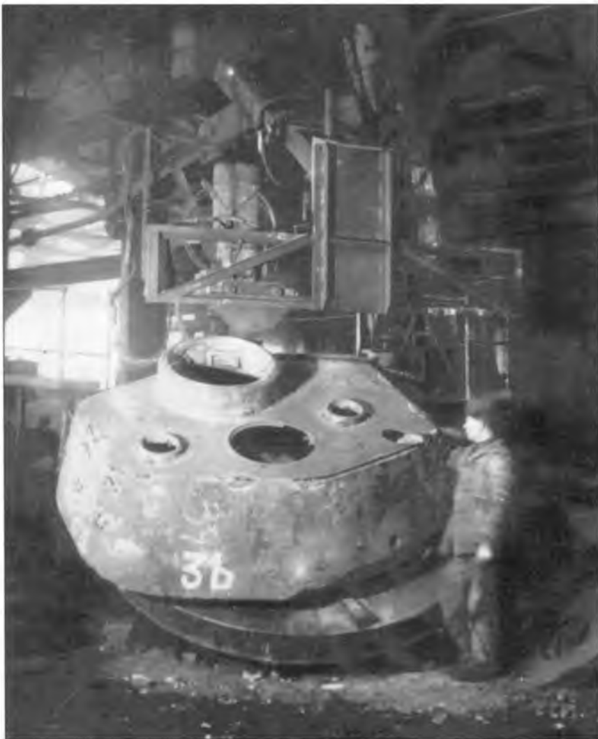
Приварка полуавтоматом крыши башни Т-34-85. Завод № 112, 1945 г.
