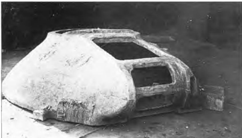
Отливка башни опытного образца модернизированного танка ИС. 1944 г.
