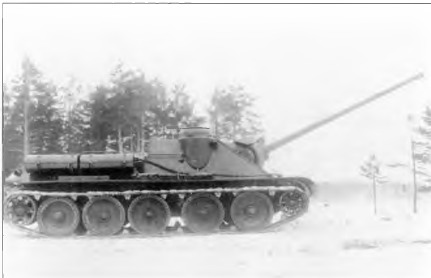
Испытания 85-мм орудия Д-5С-85БМ в самоходе СУ-100. 1944 г.
