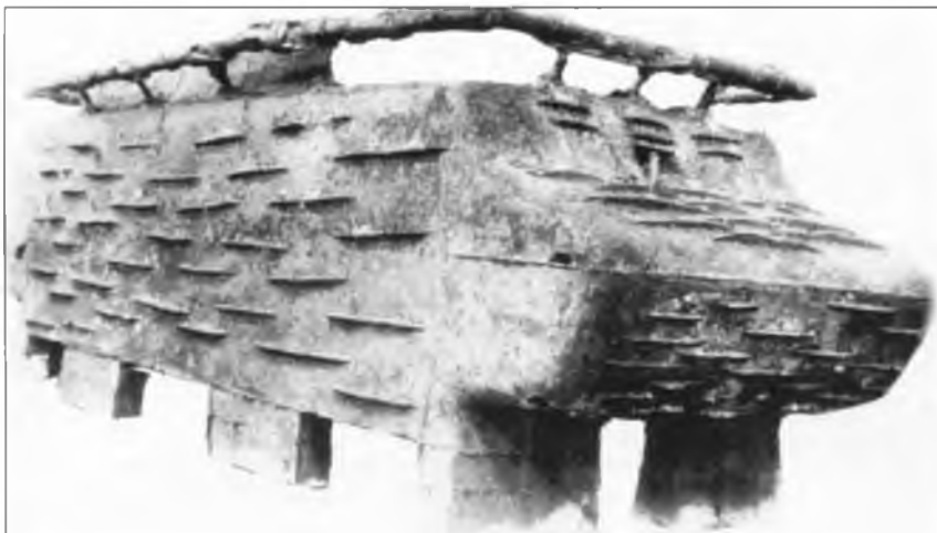
Пробная отливка корпуса танка КВ. Начало 1941 г.
