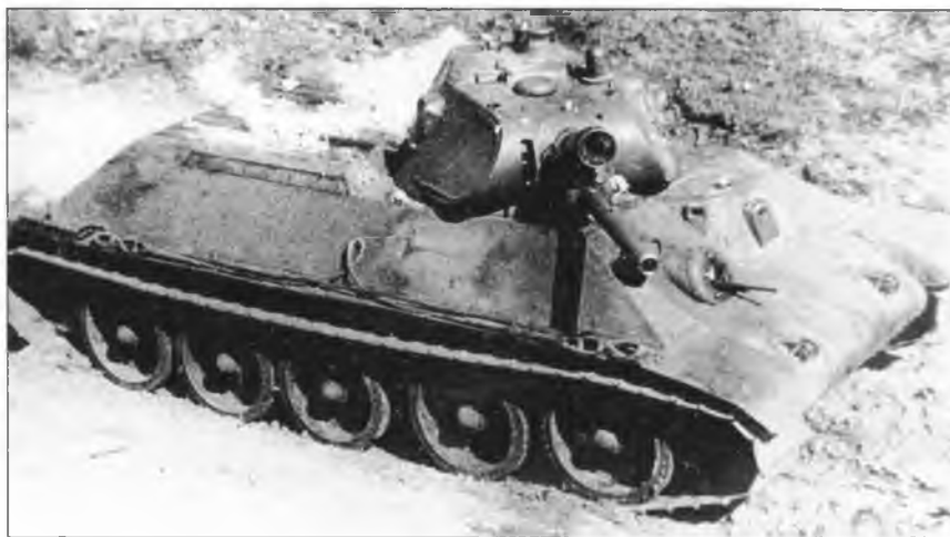
Испытания танка А-34 № 2 на огнестойкость. 1940 г.
