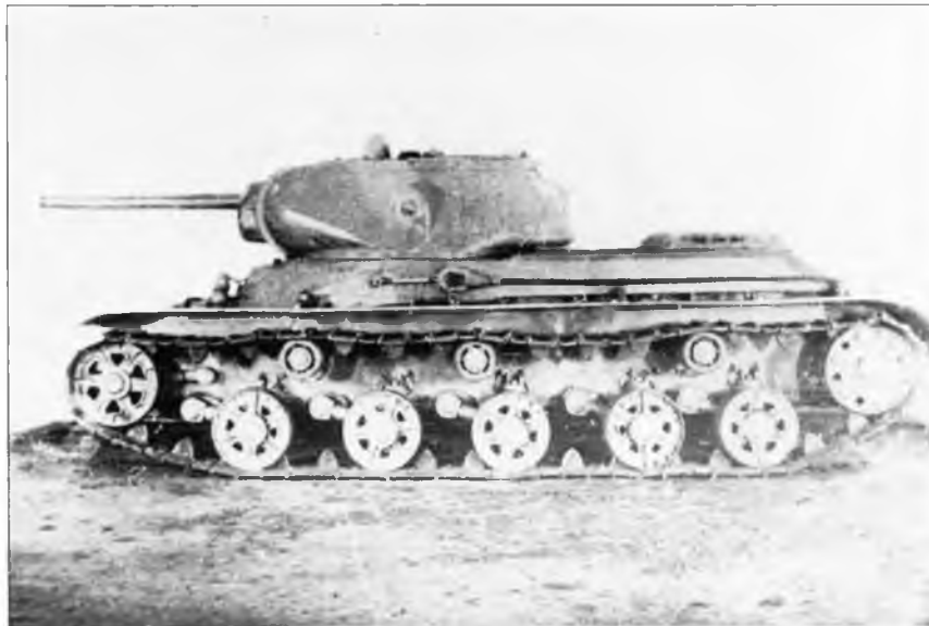
Танк KB-13 с траками танка Т-34. Вид слева. 1942 г.
