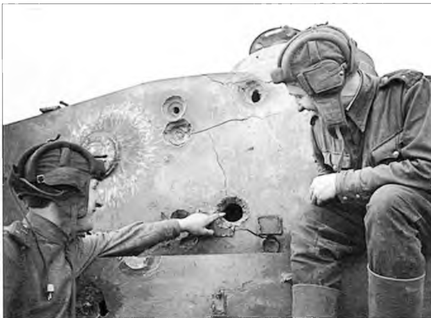
Экипаж танка Т-34 рассматривает пробойну 76-мм бронейного снаряда в башне «Тигра». Лето 1943 г.
