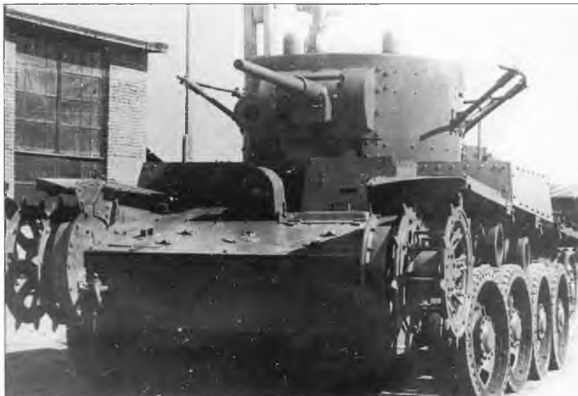
Танк Т-46 на колесном ходу, 1936 г.
