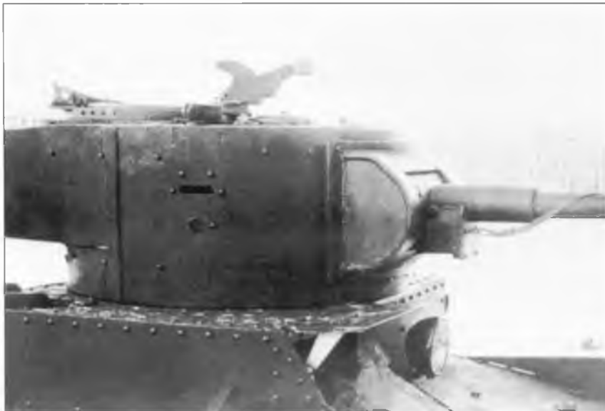
Турель П-40 на башне танка Т-26, 1936 г.
