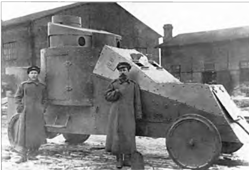
Бронеавтомобиль «Рено» забронирован по проекту штабс-капитана Мгеброва, 1916 г.
