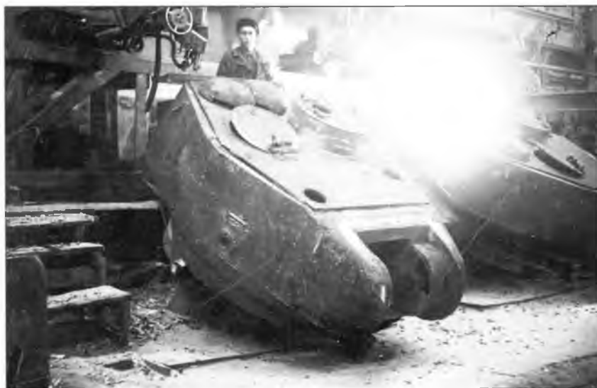
Приварка крыши башни Т-34-85. 1944 г.
