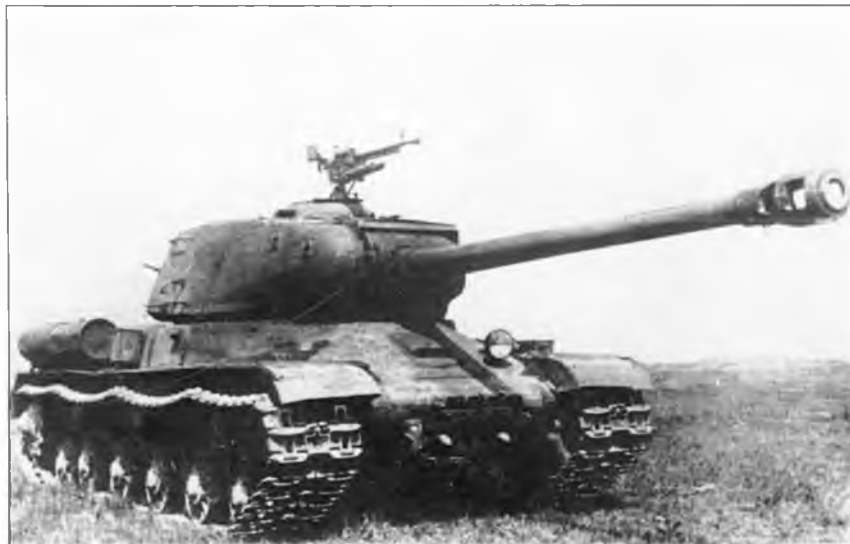
ИС-2 со «спрямленным носом», литой носовой деталью и пулеметом ДШК. 1944 г.
