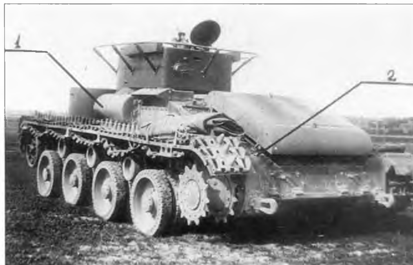
Эталонный танк Т-29, вид сзади. Цифрами показано химооборудование, 1937 г.
