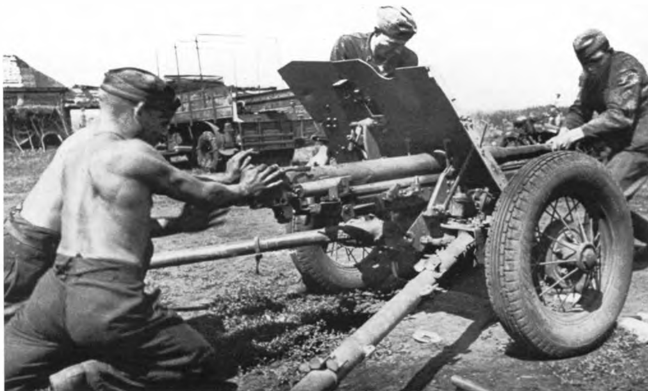
Немецкие солдаты за ремонтом Pak 184 (r) – 45-мм советского противотанкового орудия образца 1934 года. Группа армий «Юг», июль 1942 года (АСКМ).
