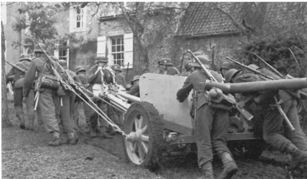
На этом фото хорошо видно, каким образом использовались специальные троса для транспортировки, входившие в комплект 75-мм пушки Рак 40 – орудие буксирует 14 человек. Франция, октябрь 1943 года (БА).
