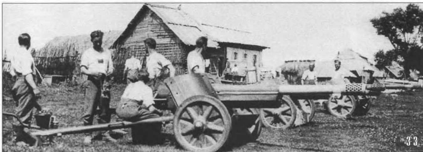
33. Батарея 75-мм противотанковых орудий Pak 97/38 из состава дивизиона истребителей танков 185-й пехотной дивизии в перерывах между боями. Лето 1942 года. Орудия окрашены в стандартный немецкий серый цвет (РГАКФД).
