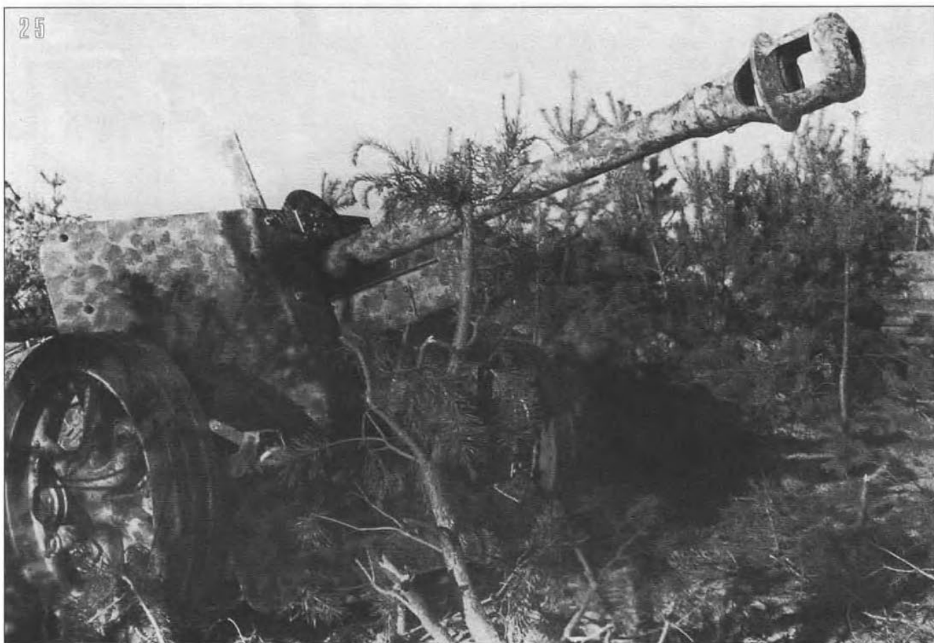
25. Трофей Красной Армии – 75-мм противотанковая пушка Pak 40, захваченная в ходе контрнаступления войск Центрального фронта на орловском направлении. Июль 1943 года. Ствол орудия находится в откате, обратите внимание на оригинальный «точечный» камуфляж (АСКМ).
