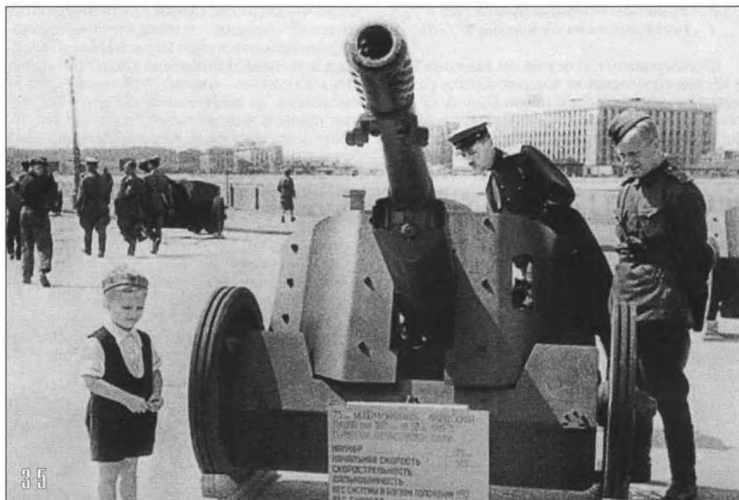
36. 75-мм противотанковое орудие Pak 97/38, подбитое и захваченное частями Красной Армии во время одной из атак. Калининский фронт, 1942 год. Хорошо видна конструкция дульного тормоза пушки (АСКМ).
