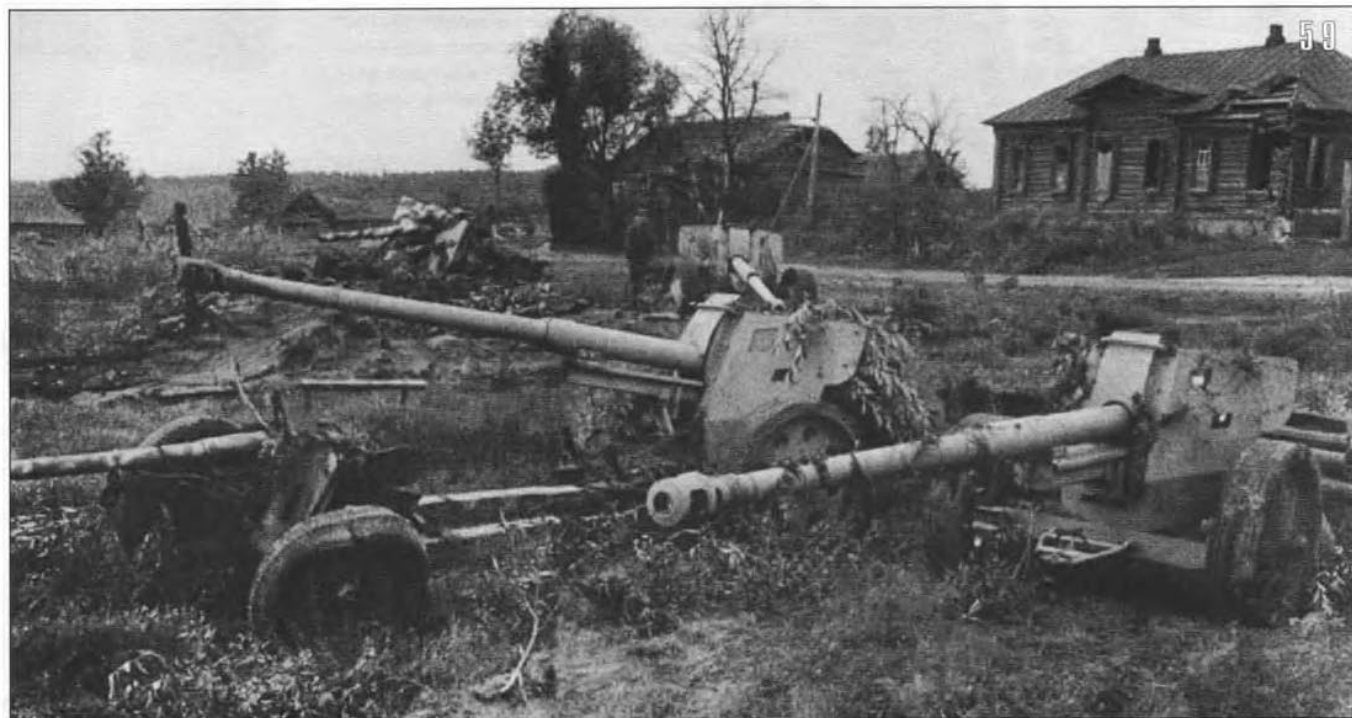
59. 88-мм противотанковые орудия Pak 43/41, захваченные частями Красной Армии в ходе контрнаступления на брянском направлении. Брянский фронт, август 1943 года. Возможно, это одни из первых 88-мм орудий Pak 43/41, захваченные советскими войсками. Пушки окрашены в желтый цвет, слева видна разбитая 76,2-мм противотанковая пушка Pak 36(r). (АСКМ).
