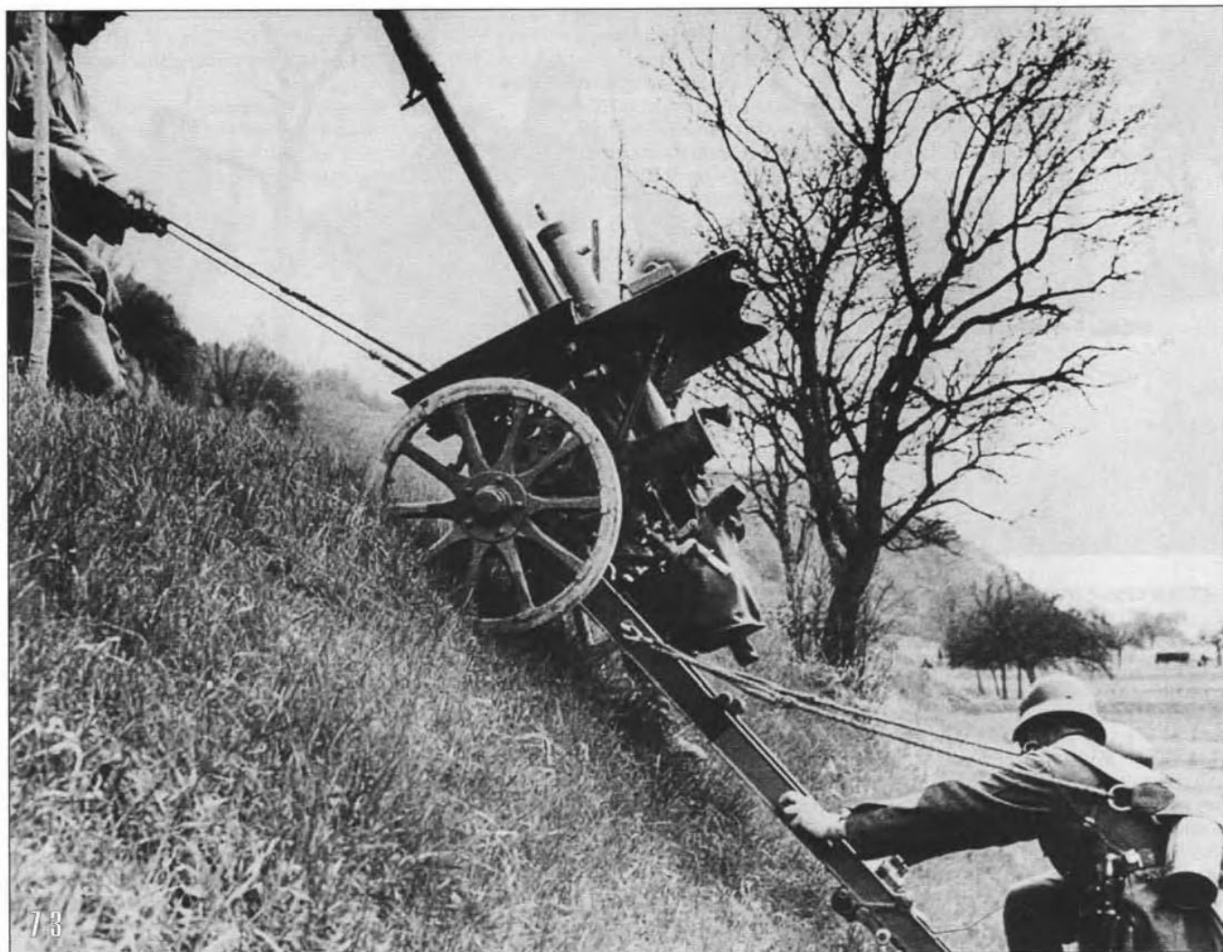
73. Подъем в гору 47-мм противотанковой пушки Рак 36(t). Югославия, весна 1940 года. Как и немецкие противотанковые орудия, артсистемы чехословацкого производства имели в своем комплекте специальные тросы, которые облегчали расчету транспортировку пушек по местности вручную (РГАКФД).
