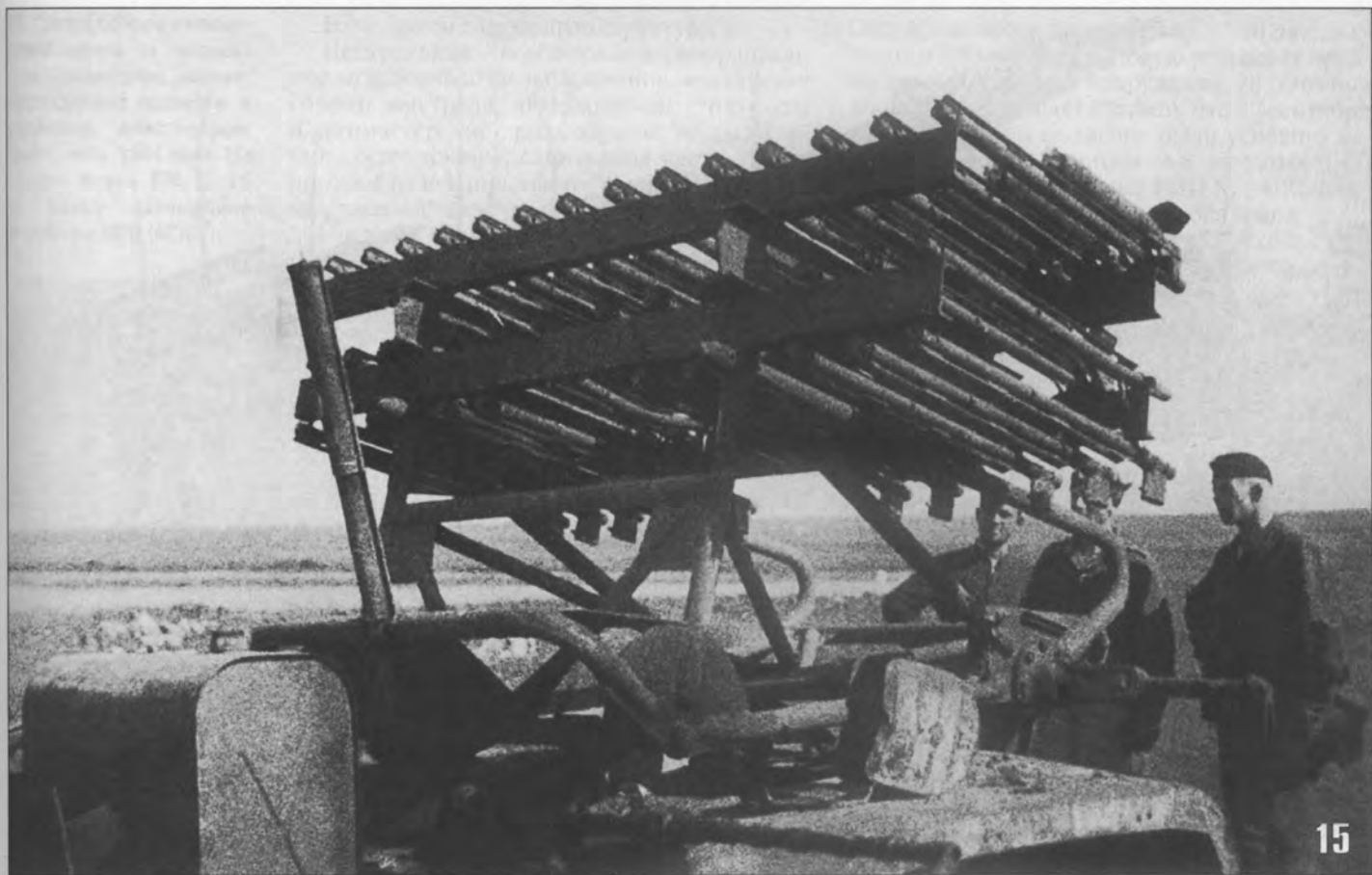
15, 16. Две БМ-8-36 на шасси автомобиля ЗИС-6, захваченных немецкими войсками. Северо-Кавказский фронт, август 1942 года. Обратите внимание, что на направляющих обеих машин установлены снаряды (АСКМ).
