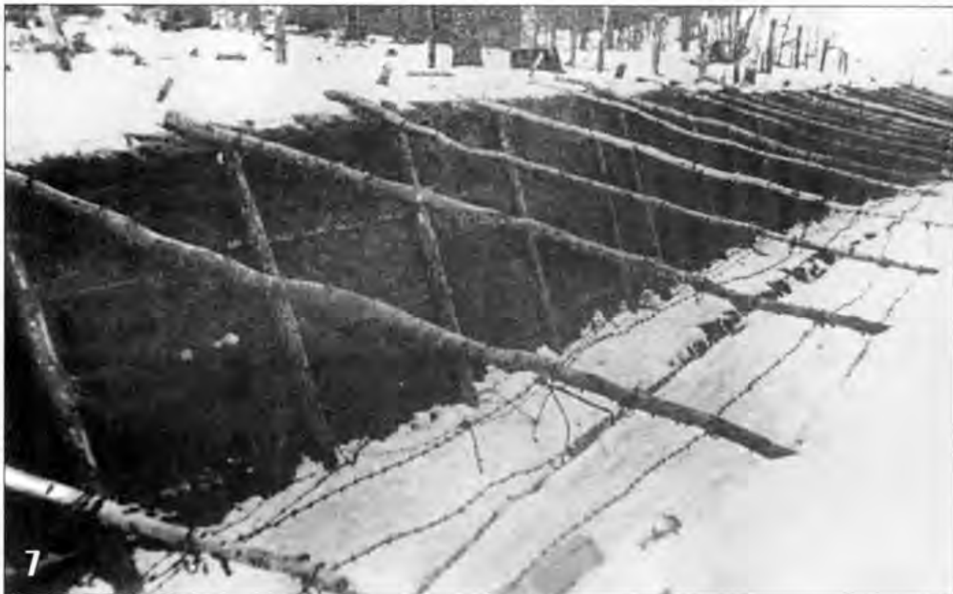
7. Противотанковый эскарп на «линии Маннергейма». Карельский перешеек, февраль 1940 года (ЦМВС).
