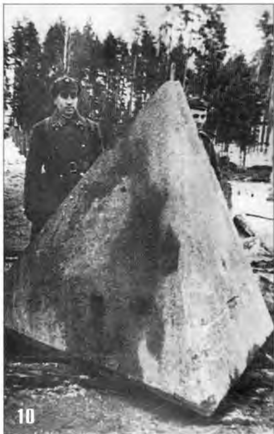
10. Железобетонная надолба высотой 2 метра. Карельский перешеек, декабрь 1939 года (ЦМВС).
