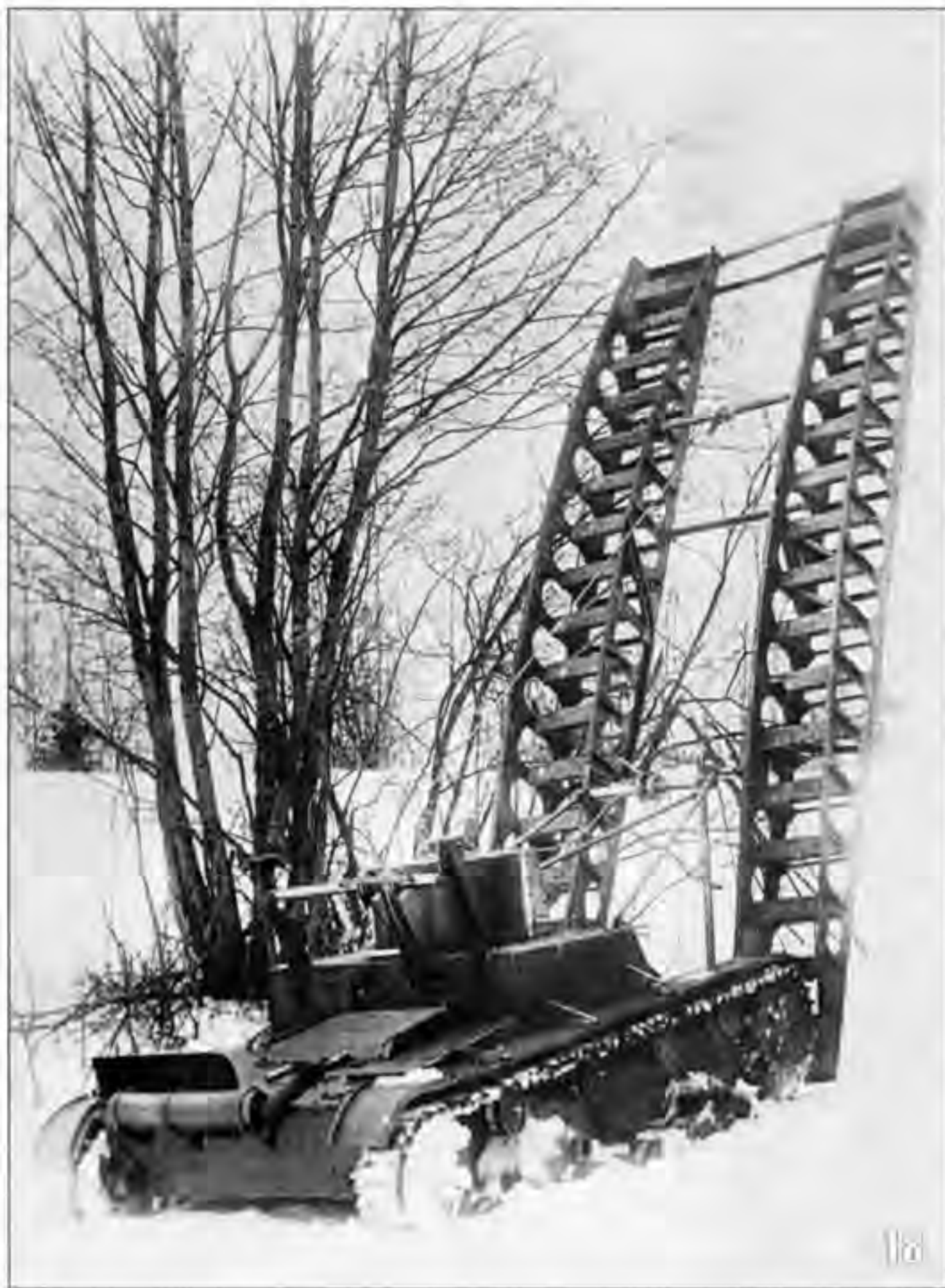
18. Саперный танк СТ-26. Такие машины использовались в составе 35-й легко-танковой бригады (АСКМ).
