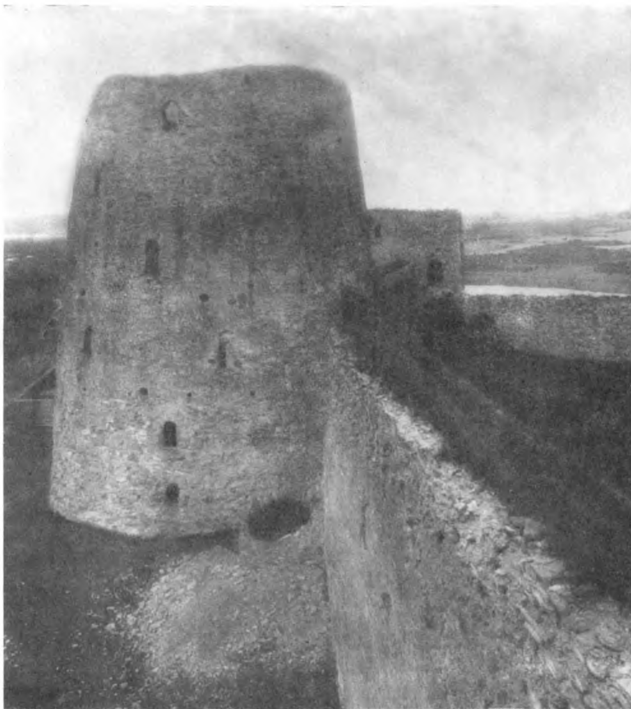
Изборск. Башня «Вышка». 1330. Перестроена в конце XV—XVI вв.
