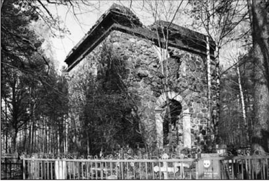
Поляны. Руины колокольни церкви Уусикиркко
