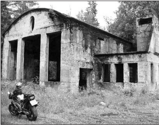
Руины финской электростанции в окрестностях посёлка Зелёный Холм
