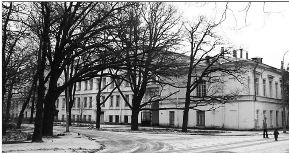
1-й (Главный) корпус Лесотехнической академии. 1826–1886 годы, архитекторы А. Д. Неллигер, К. А. Тон, Р. Л. Першке
