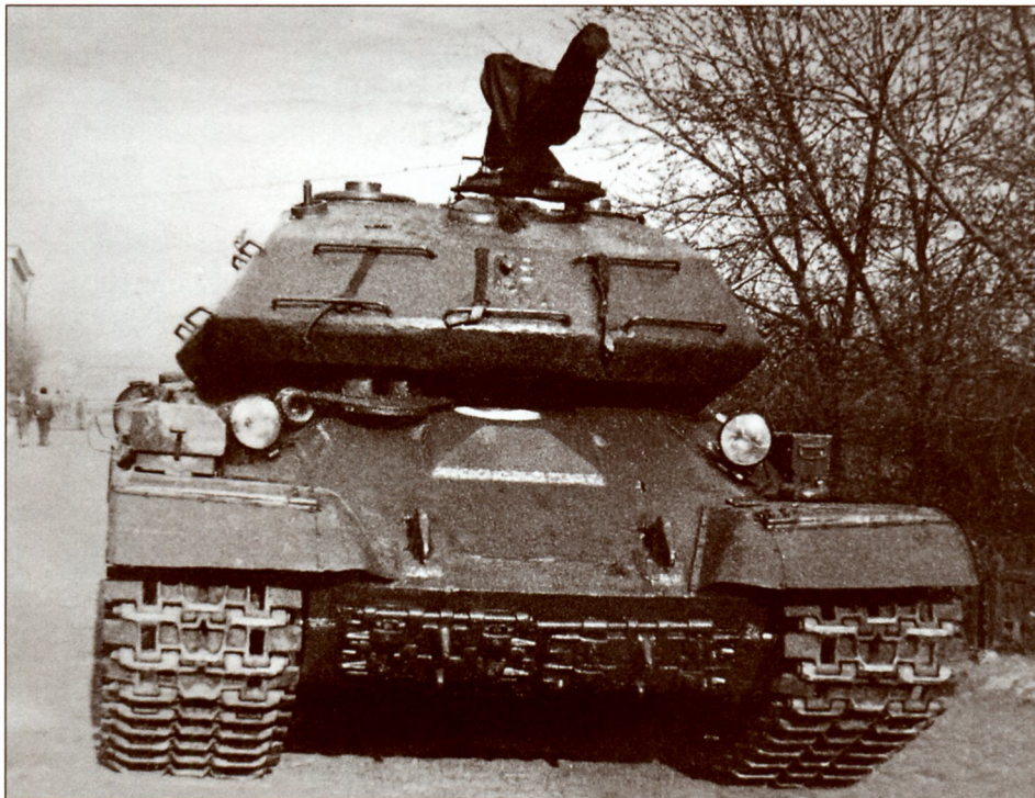
Серийный танк ИС-4 перед началом министерских испытаний, вид спереди. Апрель 1947 года. Хорошо виден открытый люк механика-водителя (РГАЭ)
