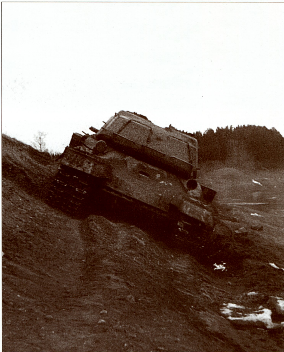
Дополнительные испытания танка «объект 701» № 5 — машина преодолевает косогор в 20 градусов. НИБТ полигон. Весна 1945 года (ЦАМО)
