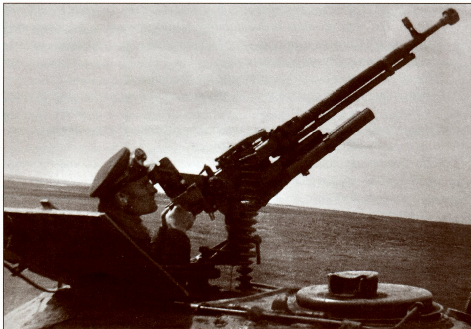
Серийный танк ИС-4 во время проведения министерских испытаний – стрельба из зенитного пулемета ДШК по воздушным целям. Весна-лето 1947 года (РГАЭ)
