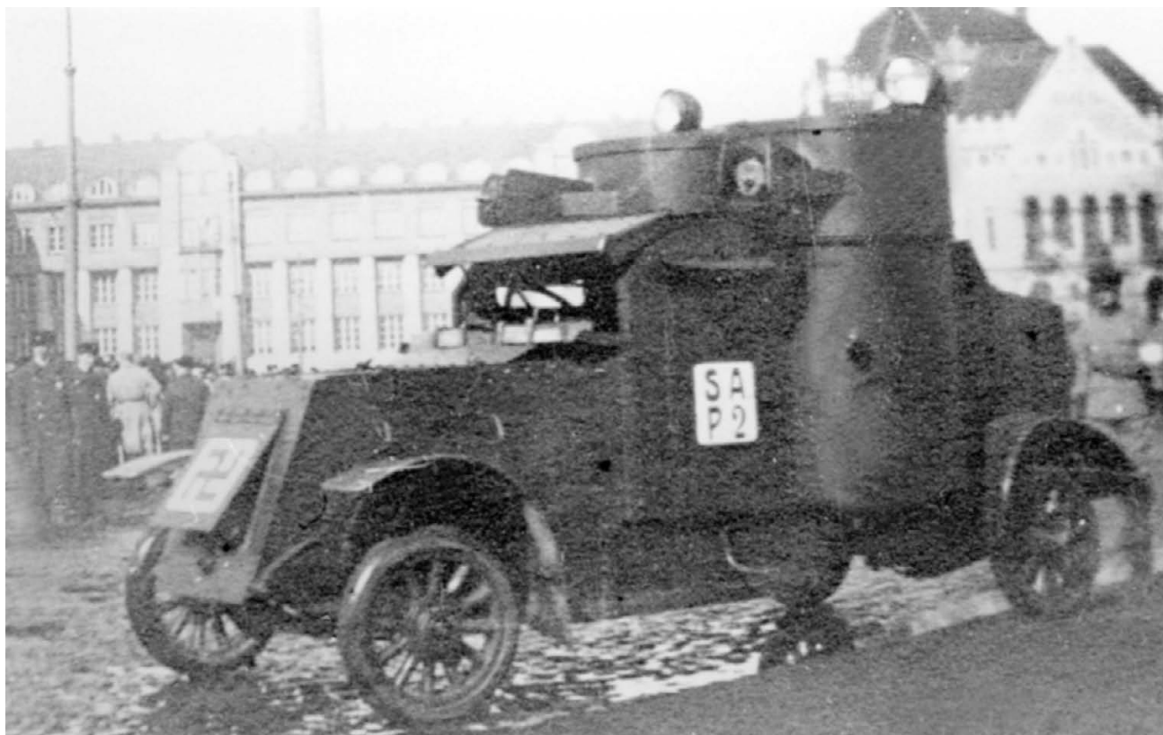
Броневомобиль «Остин» 3-й серии в составе финской армии, начало 1920-х годов. Колеса не «родные», на бронелисте перед радиатором нанесена финская свастика, на левом борту виден номер броневика SA P2. В 1918 году финны захватили два таких броневика в боях с отрядами Красной гвардии, и эксплуатировали их до середины 1920-х годов (из коллекции Е. Муикку).
