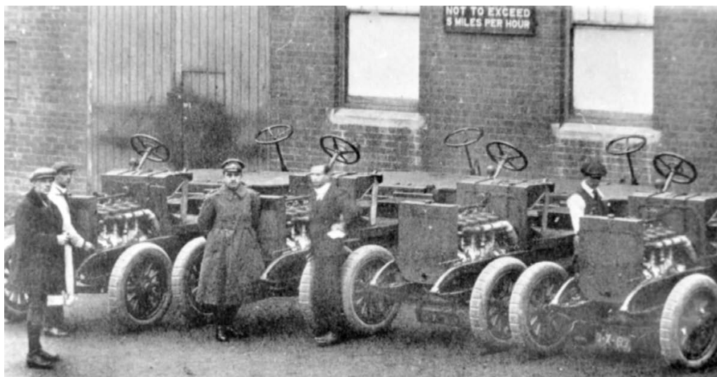
Шасси «Остин» с кормовым постом управления перед отправкой в Россию. 1917 год. Такие же шасси использовались для изготовления броневых автомобилей «Остин» 3-й серии (АСКМ).
