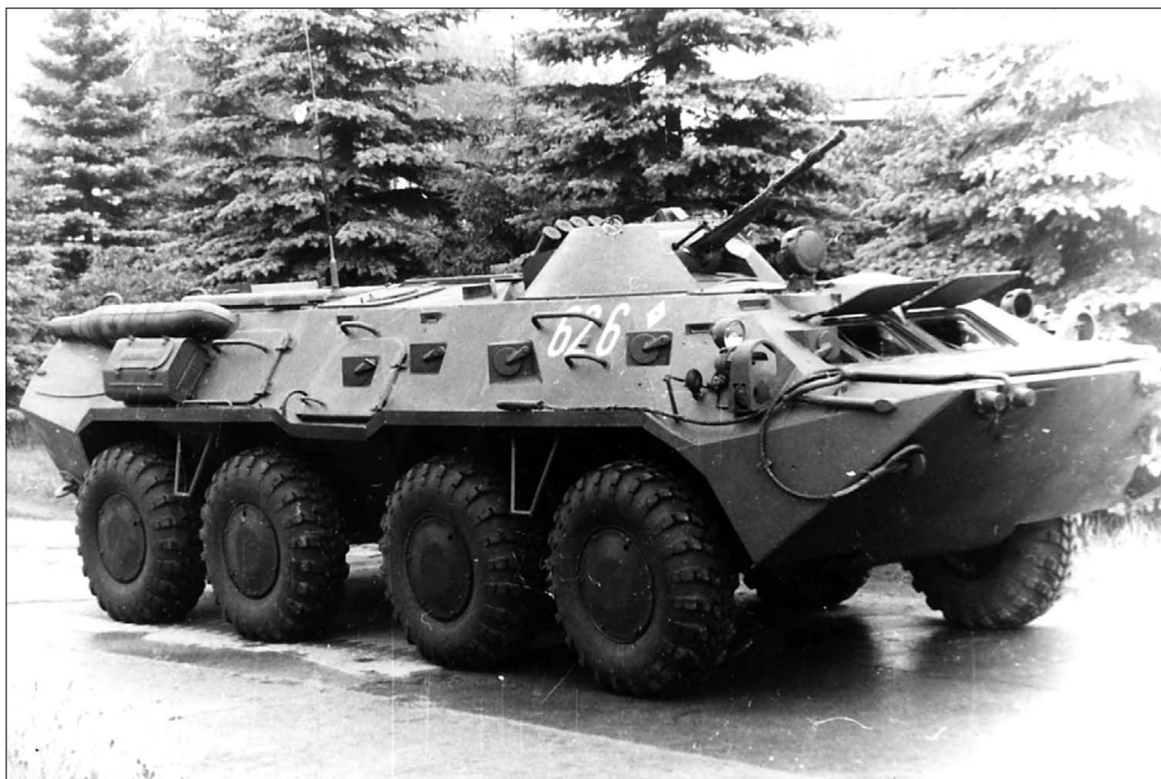
На этой машине установлены типичные для БТР-80 волноотражательный щиток и ограждение фар, но бортовые поручни еще короткие
