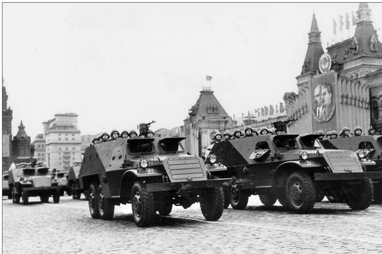
Бронетранспортеры БТР-152 проходят по Красной площади. Жалюзи радиаторов закрыты по-боевому. У второй, третьей и т.д. машин в шеренге откинuty верхние створки правых броневых дверей — так было легче визуально контролировать равнение. Москва, 7 ноября 1954 года
