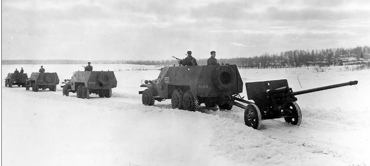
Колонна боевых машин на учениях. Зима 1957 года. Тяговые свойства БТР-152 позволяли ему буксировать артиллерийские системы калибром до 100 мм различных типов (в данном случае — 57-мм пушку ЗИС-2)
